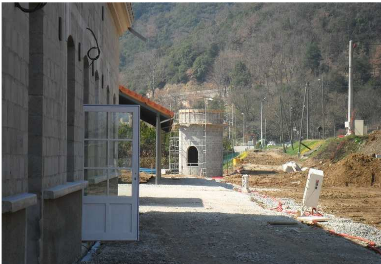
Début des travaux de décaissement dans la rampe située à la sortie de la gare de la Ceillère, du 28 pour mille au démarrage! (la voie passera à droite du château d'eau).
