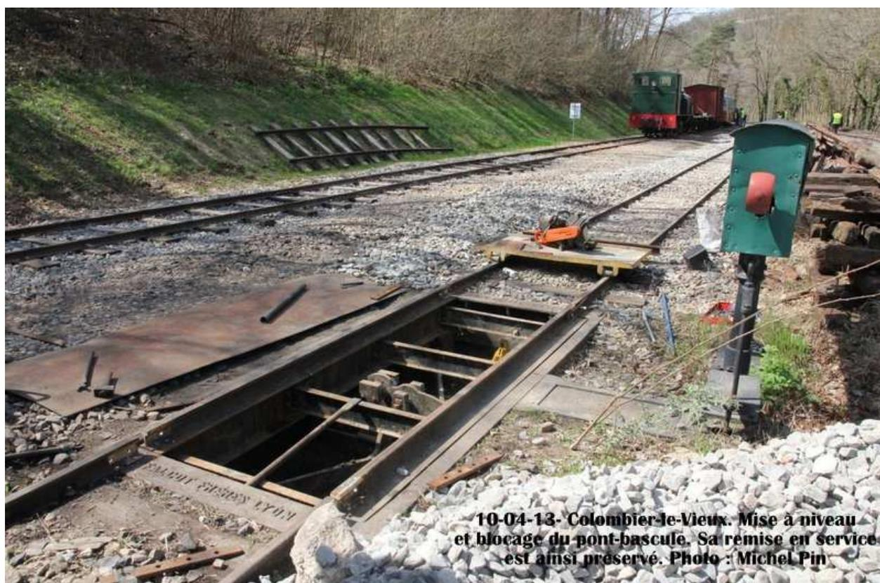
**10-04-13- Colombier-le-Vieux. Mise à niveau et blocage du pont-bascule. Sa remise en service est ainsi préservé. Photo : Michel Pin**
