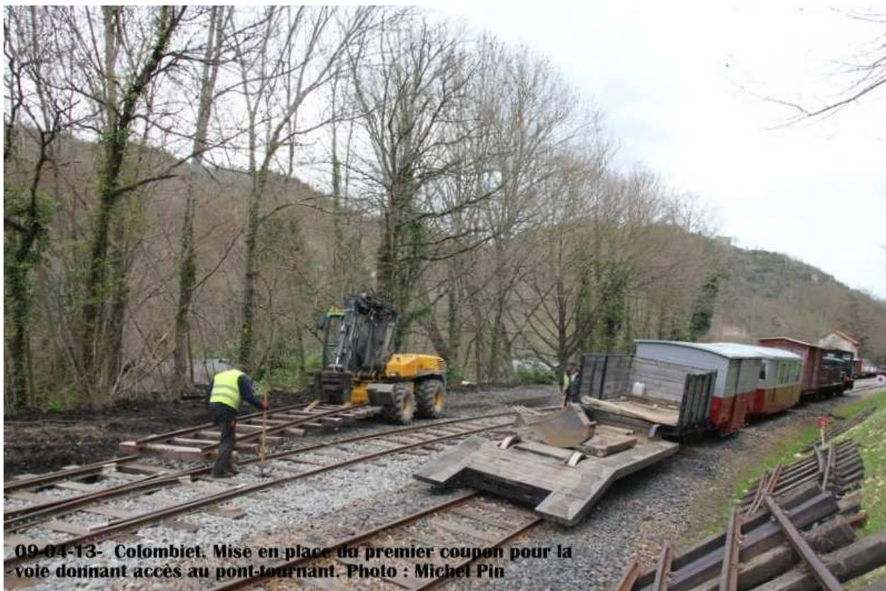
**09-04-13- Colombier. Mise en place du premier coupon pour la voie d'abord accès au pont-tournant. Photo : Michel Pin**
