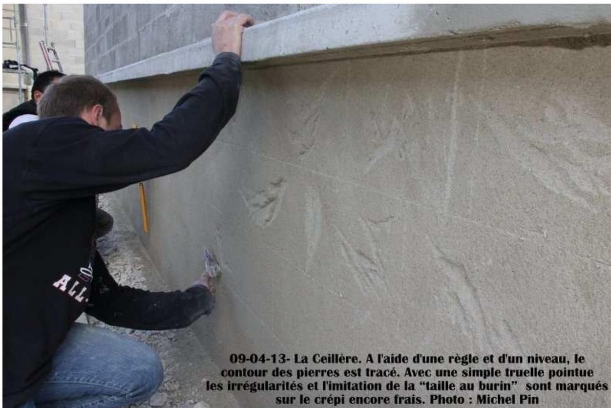
**09-04-13- La Ceillère. A l'aide d'une règle et d'un niveau, le contour des pierres est tracé. Avec une simple truelle pointue les irrégularités et l'imitation de la "taille au burin" sont marqués sur le crépi encore frais. Photo : Michel Pin**
