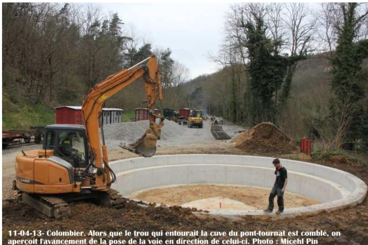
**11-04-13- Colombier. Alors que le trou qui entourait la cuve du pont-tournant est comblé, on aperçoit l'avancement de la pose de la voie en direction de celui-ci. Photo : Micheł Pin**
