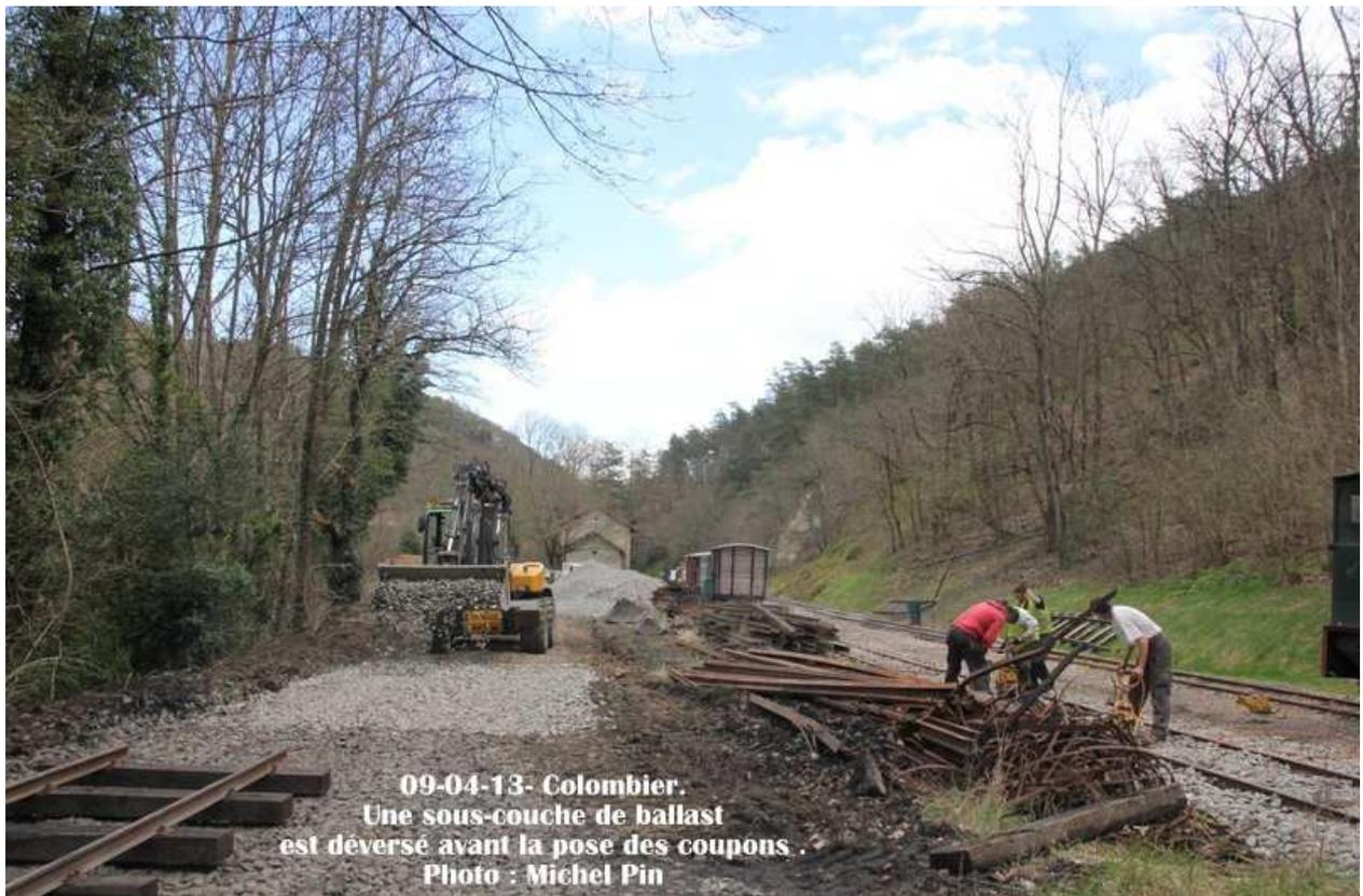
Sur la nouvelle plateforme, après décaissement, une sous couche de ballast est posée avant la pose de coupons de rails.
