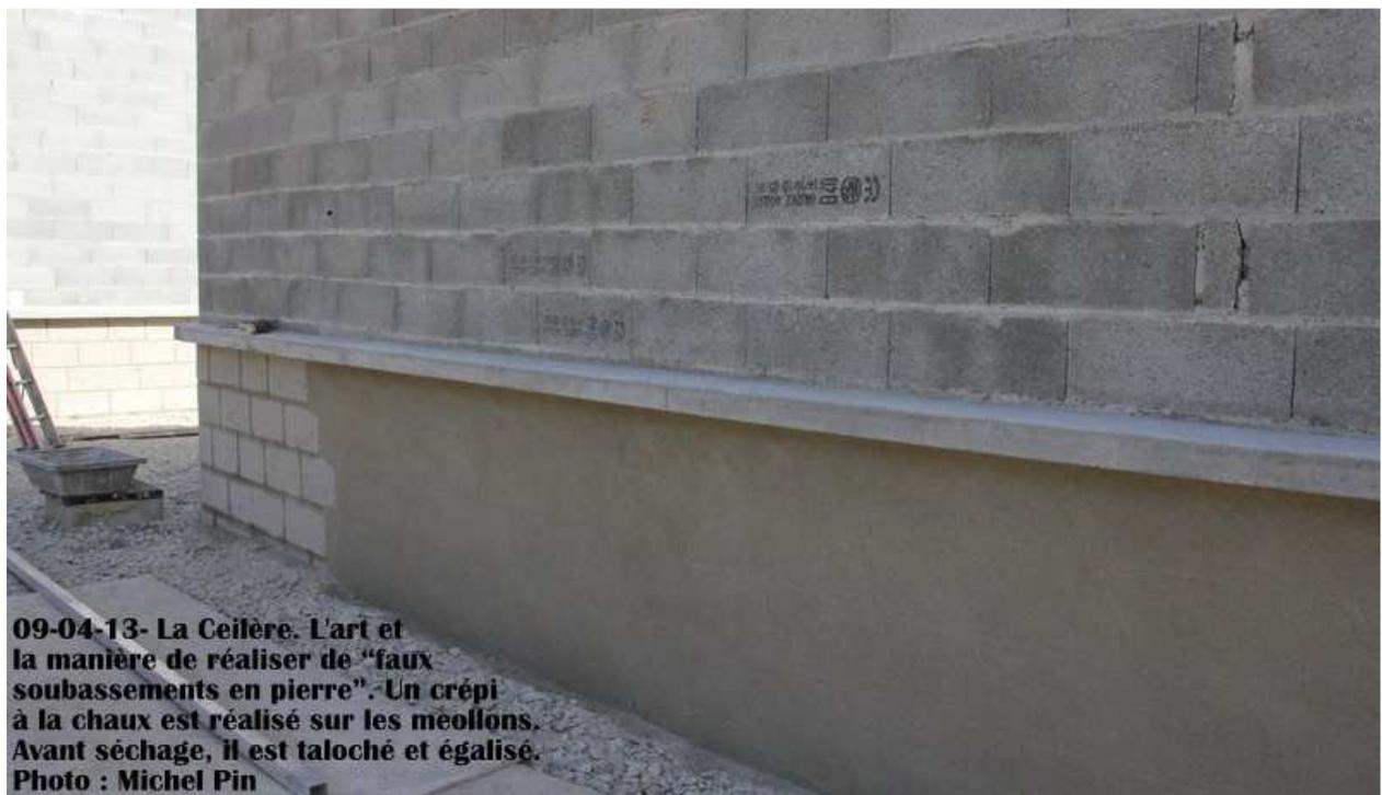
**09-04-13- La Ceillère. L'art et la manière de réaliser de "faux soubassements en pierre". Un crépi à la chaux est réalisé sur les meollons. Avant séchage, il est taloché et égalisé. Photo : Michel Pin**
