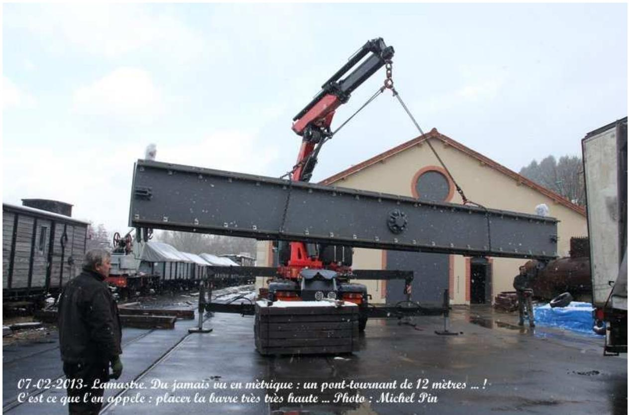
*07-02-2013- Lamastre. Du jamais vu en métrique : un pont-tournant de 12 mètres ... !
