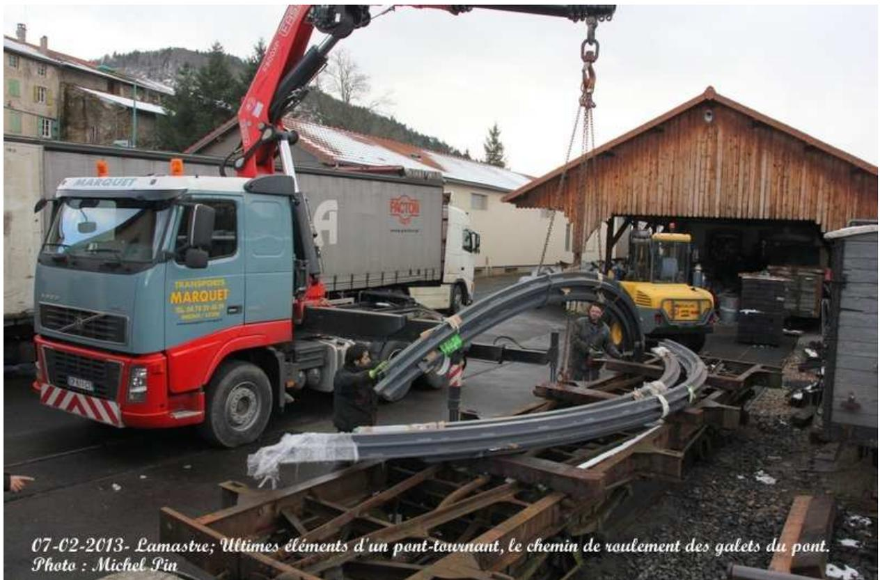
*07-02-2013- Lamastre; Ultimes éléments d'un pont-tournant, le chemin de roulement des galets du pont.
