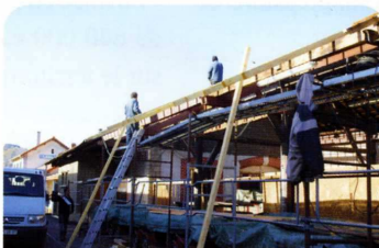
Travaux de réhabilitation des toitures des bâtiments de la gare
