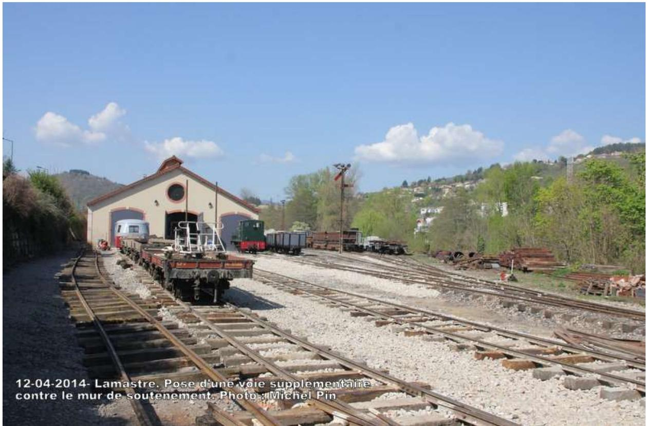
12-04-2014- Lamastre. Pose d'une voie supplémentaire contre le mur de soutènement. Photo : Michel Pin
