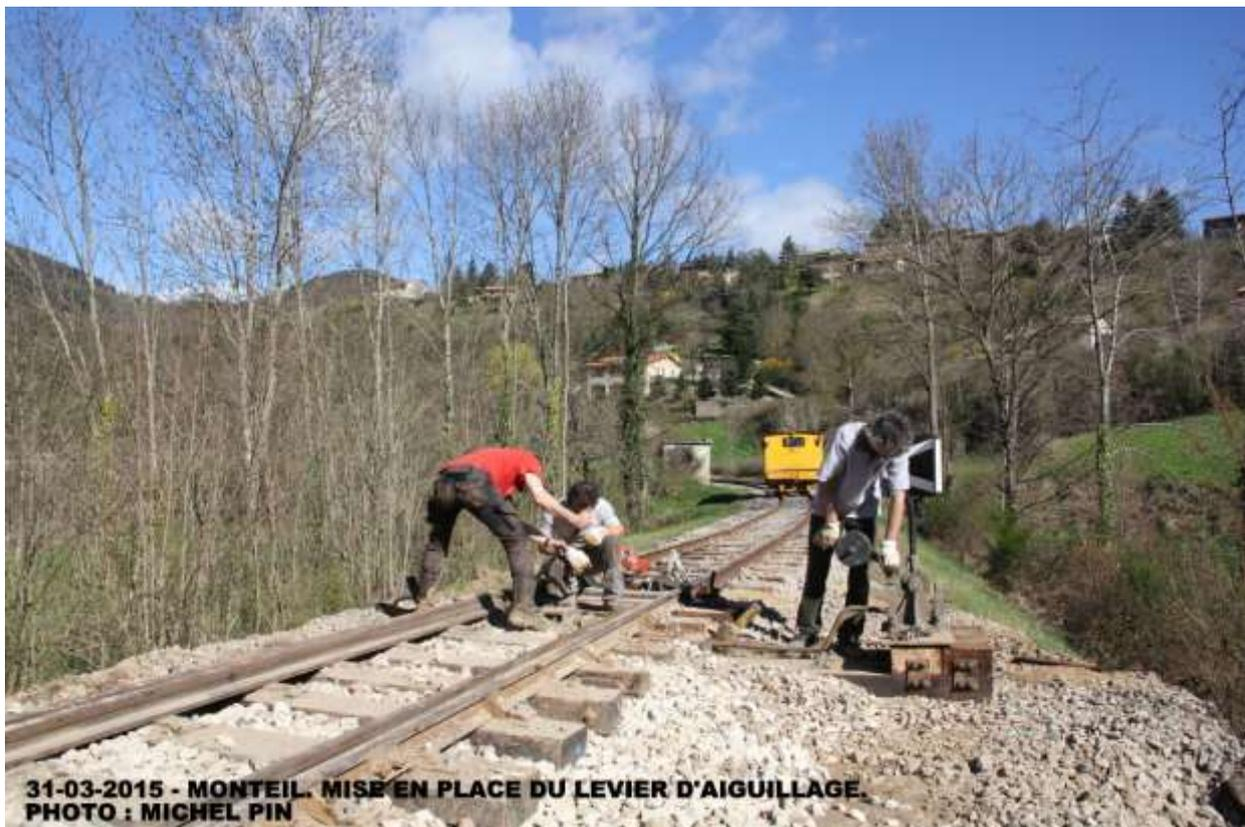
**31-03-2015 - MONTEIL. MISE EN PLACE DU LEVIER D'AIGUILLAGE.
