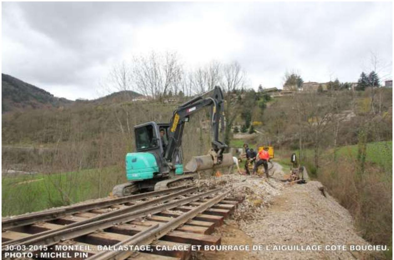
**30-03-2015 - MONTEIL. BALLASTAGE, CALAGE ET BOURRAGE DE L'AIGUILLAGE COTE BOUCIEU. PHOTO : MICHEL PIN**
