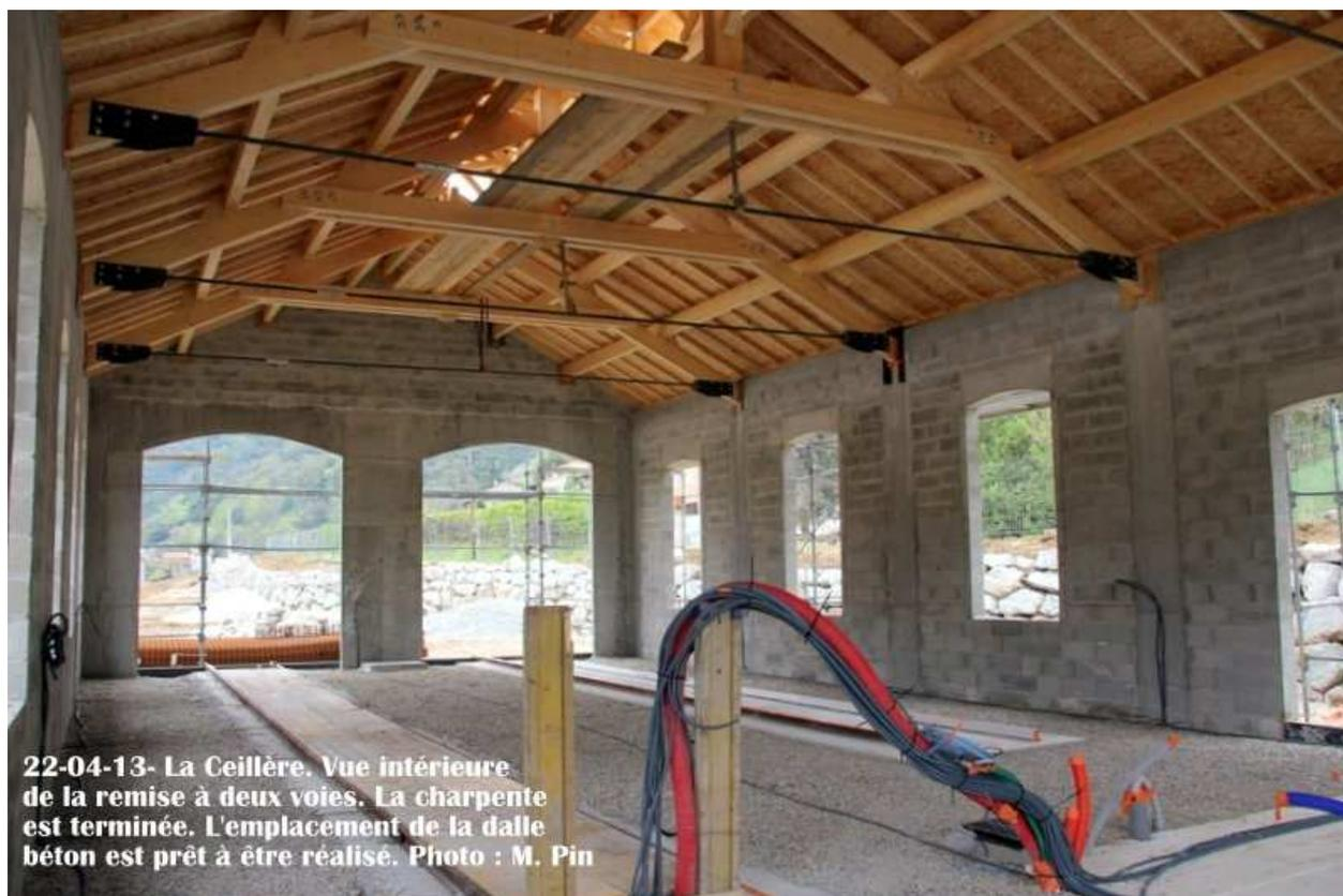
22-04-13- La Ceillère. Vue intérieure de la remise à deux voies. La charpente est terminée. L'emplacement de la dalle béton est prêt à être réalisé. Photo : M. Pin
