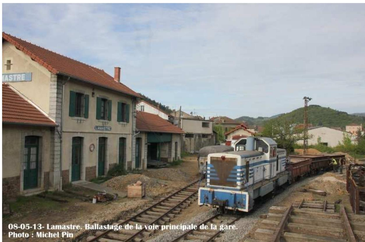
La pose de la voie principale étant terminée, l'opération ballastage a été réalisée. Plusieurs navettes de trains de ballast ont été effectuées entre la base travaux du PN 51 et la gare.
