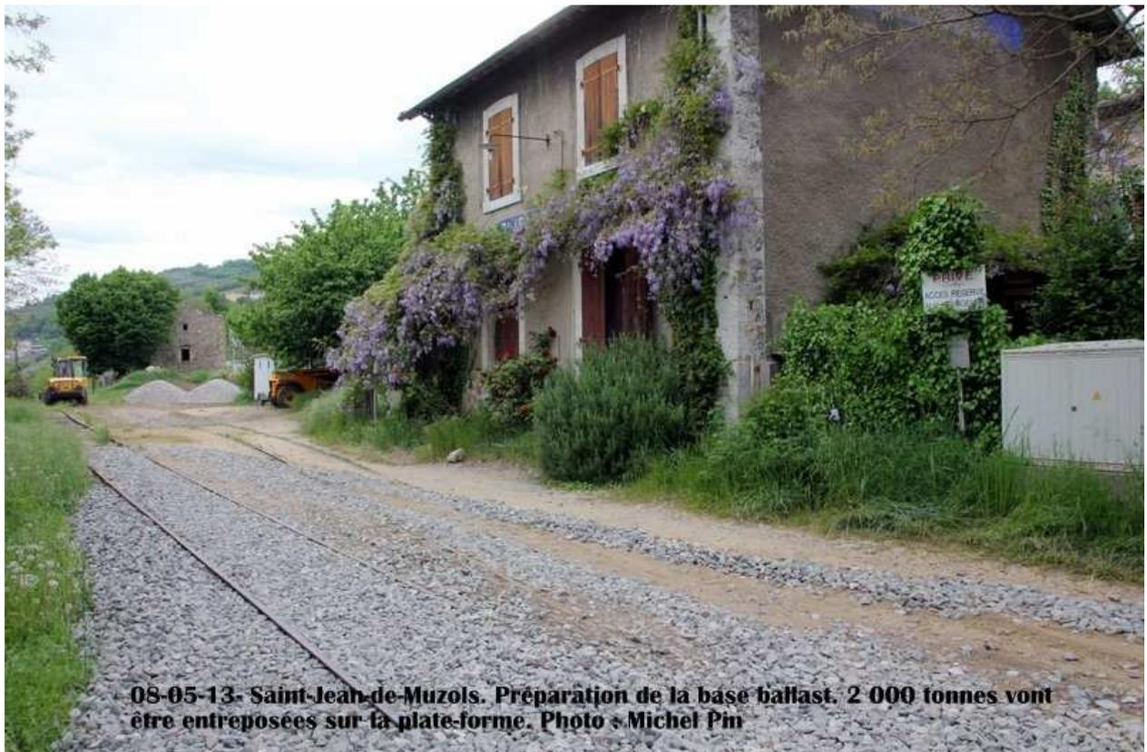
**08-05-13- Saint-Jean-de-Muzols. Préparation de la base ballast. 2 000 tonnes vont être entreposées sur la plate-forme. Photo : Michel Pin**
