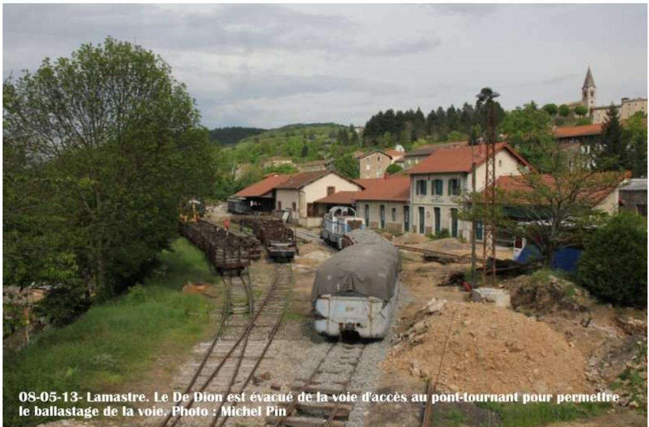
Après le déversement de plusieurs tonnes de ballast, le calage et le bourrage de la voie a commencé à être effectué à partir du nouveau signal.
