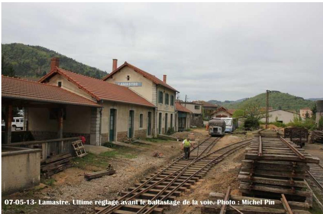
07-05-13- Lamastre. Ultime réglage avant le ballastage de la voie. Photo : Michel Pin
