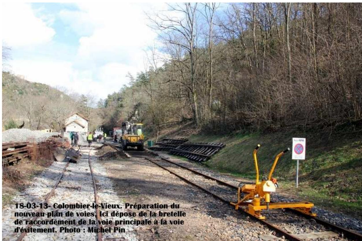
**18-03-13- Colombier-le-Vieux. Préparation du nouveau plan de voies. Ici dépose de la bretelle de raccordement de la voie principale à la voie d'évitement. Photo : Michel Pin**
