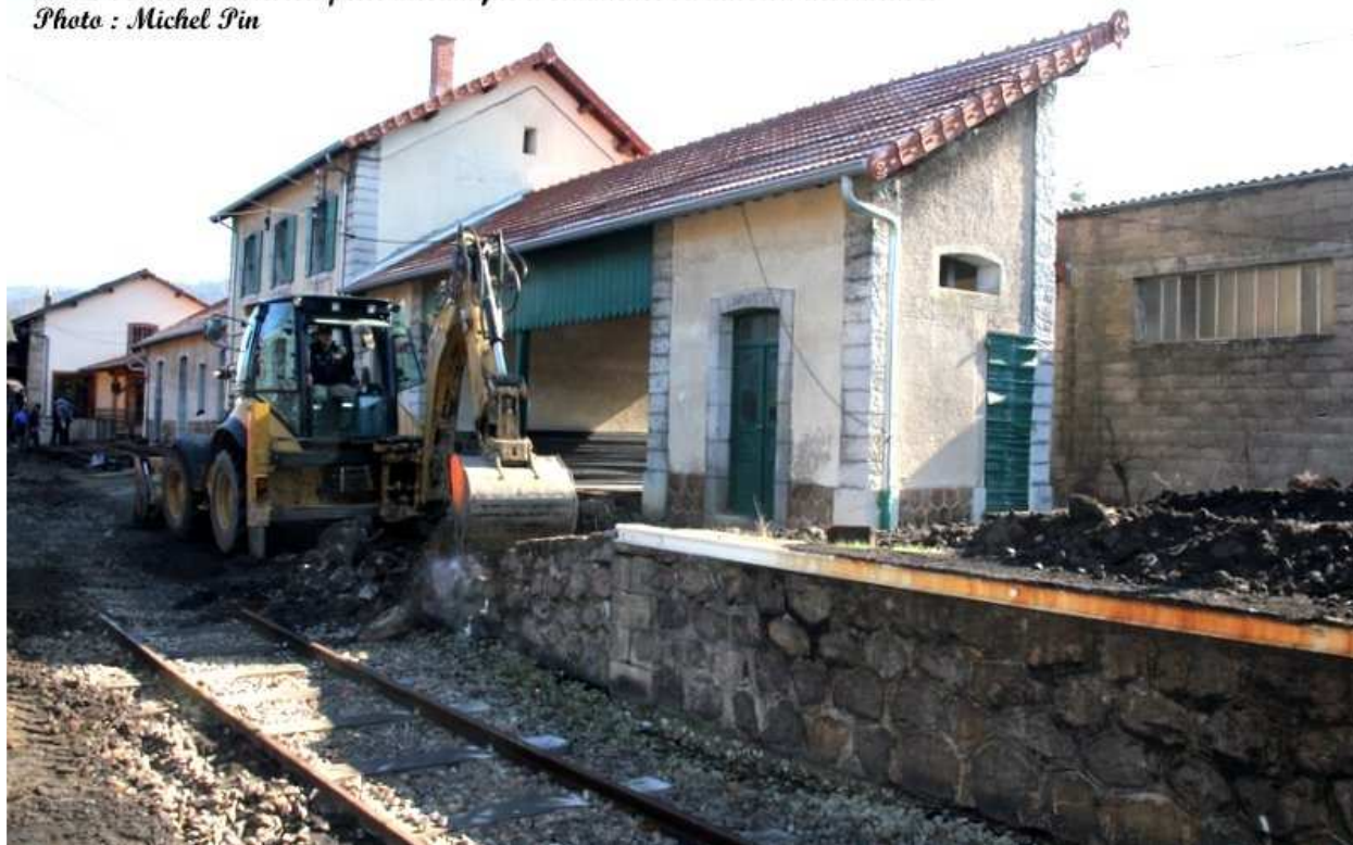
19-02-13- Lamastre. La pelle mécanique a commencé sa mission destructive. Photo : Michel Pin
