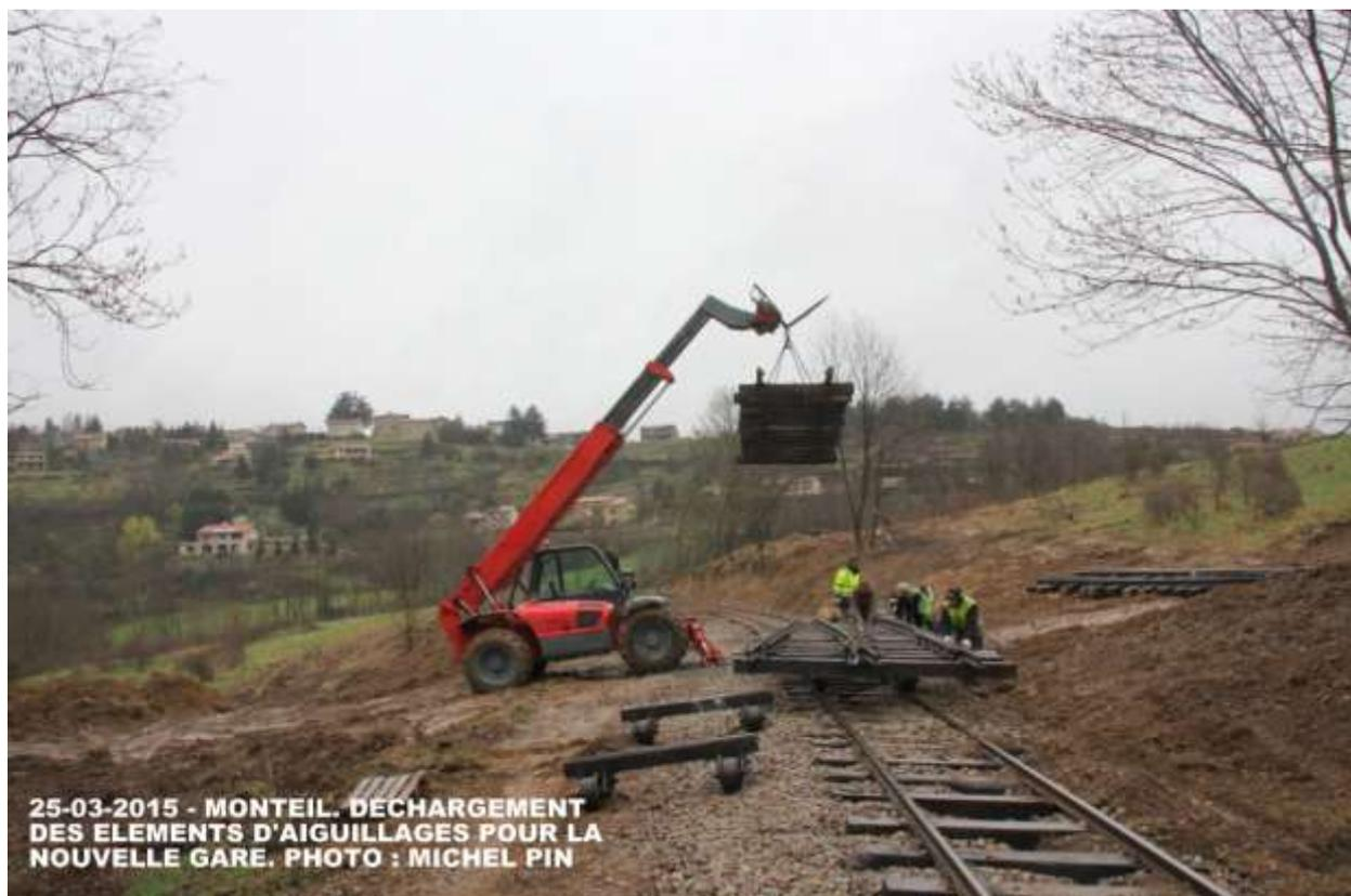
**25-03-2015 - MONTEIL. DECHARGEMENT DES ELEMENTS D'AIGUILLAGES POUR LA NOUVELLE GARE. PHOTO : MICHEL PIN**
